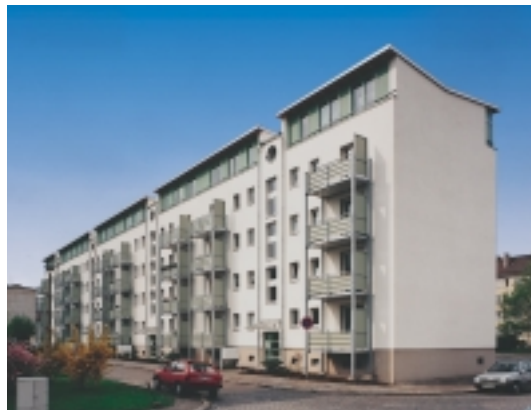
Санация жилого дома, Люнебургер штрассе, Магдебург ■ Вид наших работ: генеральное проектирование
